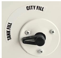
Tank Fill / City Fill Valve
